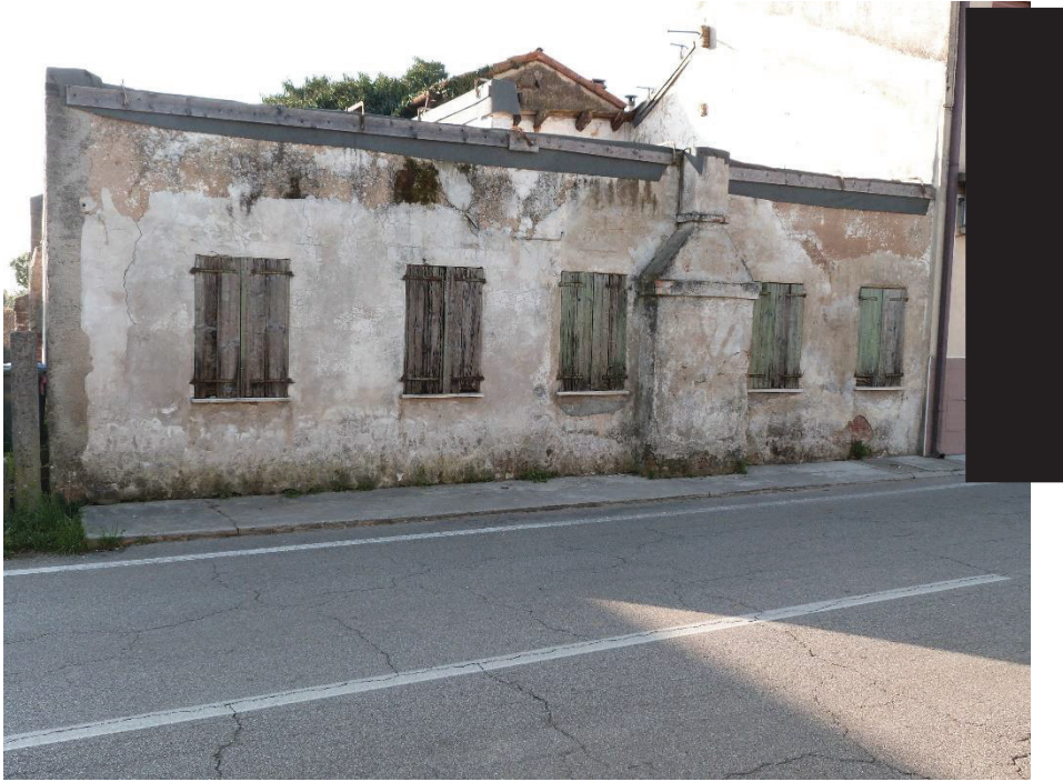
1 Prospetto del fabbricato rurale su Via Monte Grappa.
